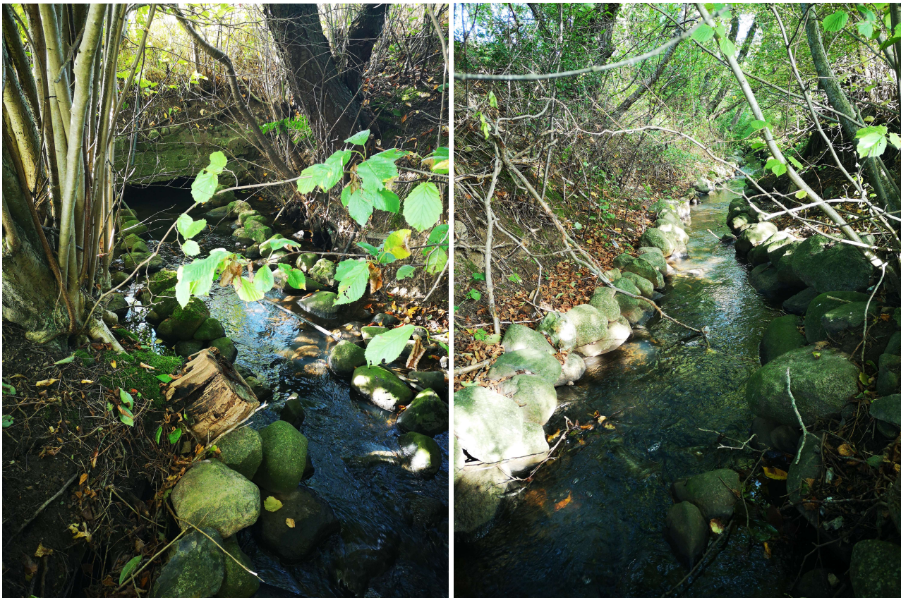
Figur 3.3: tv: kig opstrøms med udløbs under hestepassage bagerst i billedet. Th: kig nedstrøms fra samme punkt. Kilde: NIRAS A/S
